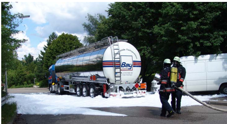
Nur ein Teil der Übung: Aufbringen des Schaumteppichs durch die Feuerwehr
